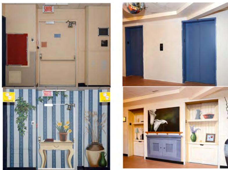
Figure 2 – Habillage / dissimulation des issues au sein de l'Institut Gériatrique de Montréal par trompe-l'œil. À gauche, la porte de l'unité. À droite, les portes de l'ascenseur
