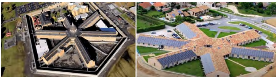
Figure 6 – À gauche, vue aérienne de la Prison de Bordeaux. À droite, vue aérienne de l'Ehpad Les Monts du Matin à Bésayes (26)
